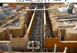
基礎型枠工事
