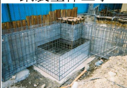
鋼製型枠工事
