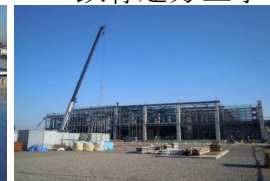
鉄骨建方工事
