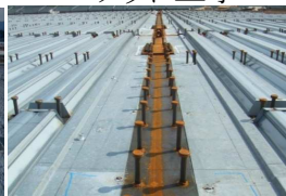
スタッド工事
